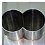
Сварка детали газового уплотнения
